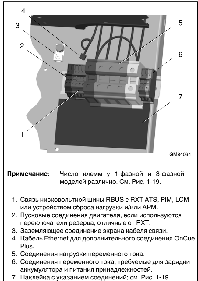
Рис. 1-18 Клеммные блоки для соединений на месте работы
