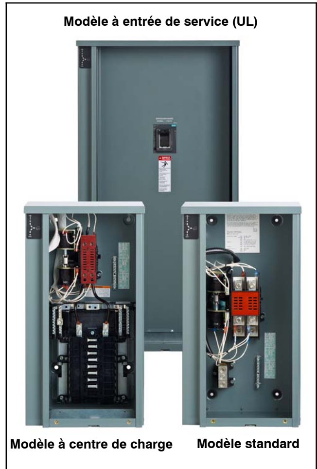
Figure 1-2 Commutateurs de transfert sélectionnés (capots retirés)
